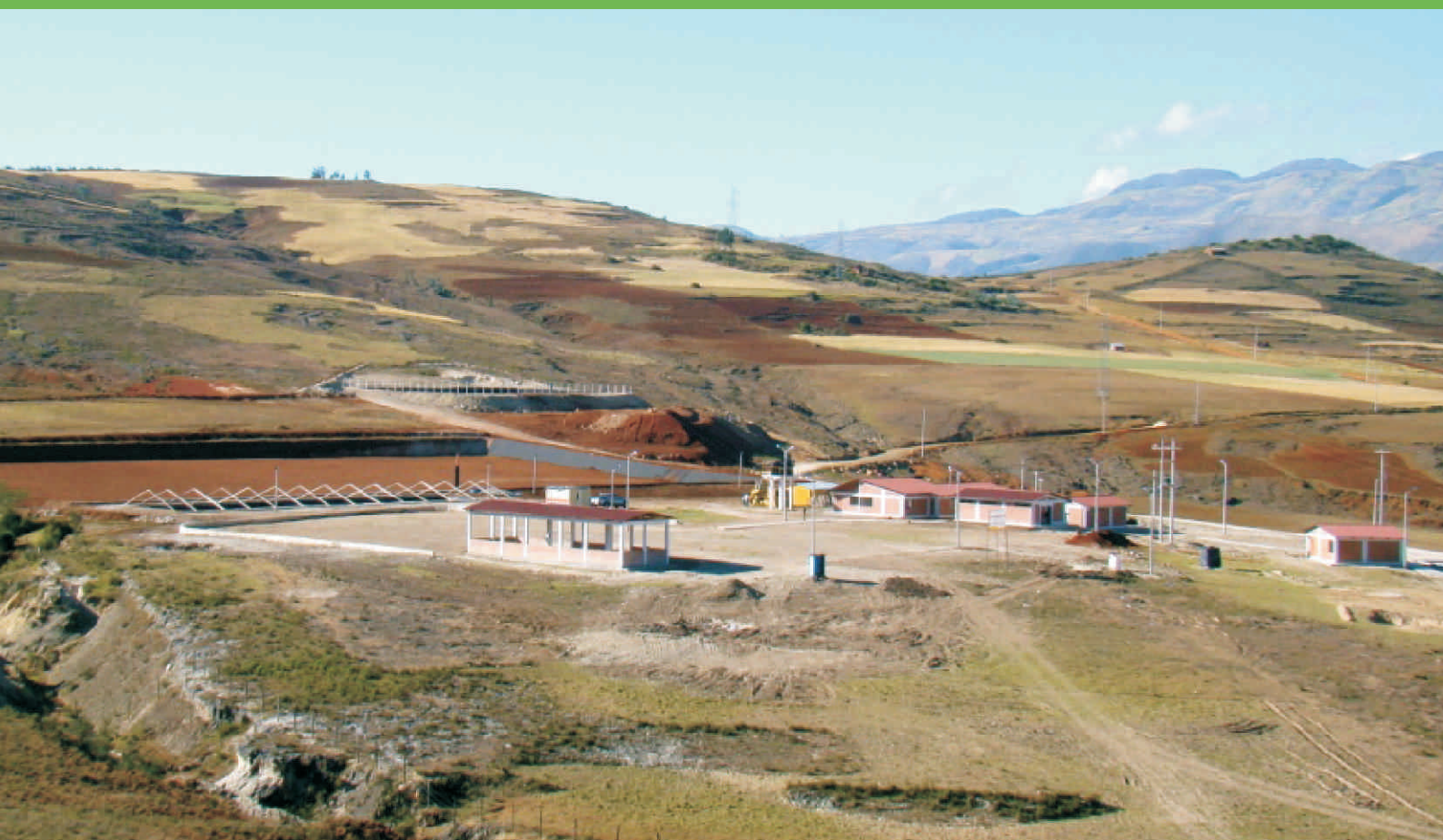
Planta de Tratamiento de Residuos de Cajamarca, Provincia de Cajamarca, Región Cajamarca
