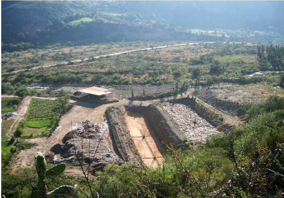
Imagen N° 1 Vista de un relleno sanitario manual.
